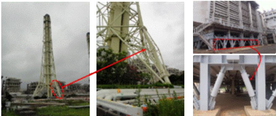
煙突「地震動の荷重を抑制・吸収する装置の追加」
