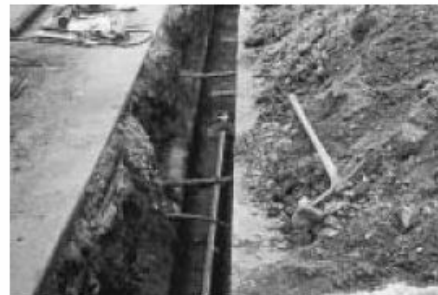
老朽化に伴う耐震化工事（扇町）
