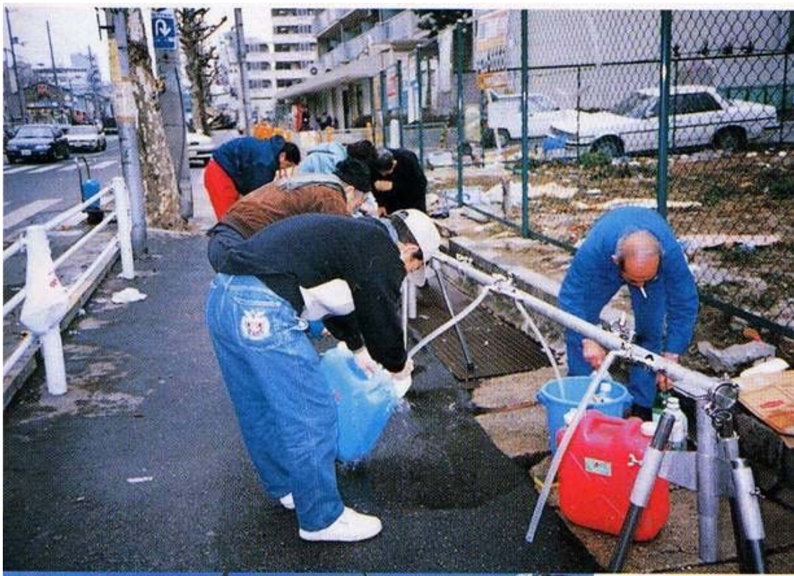
写真１１ 配水管を用いた応急給水 兵庫県南部地震 （提供）神戸市水道局
