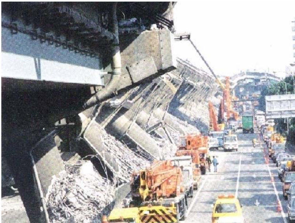
写真7 阪神高速道路の倒壊（東灘区） 兵庫県南部地震 （提供）神戸市水道局
