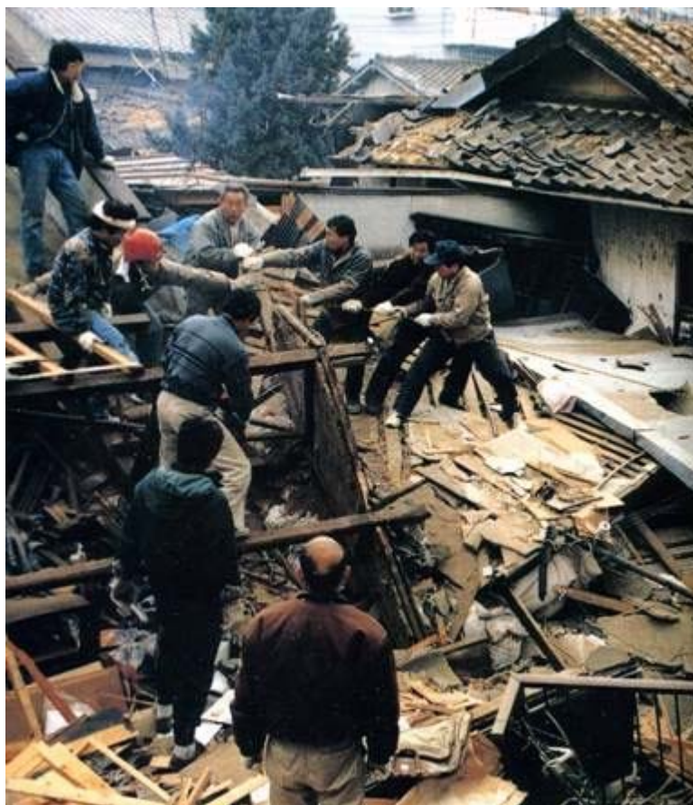
写真 10 倒壊家屋からの救出作業 兵庫県南部地震 （提供）神戸市水道局
