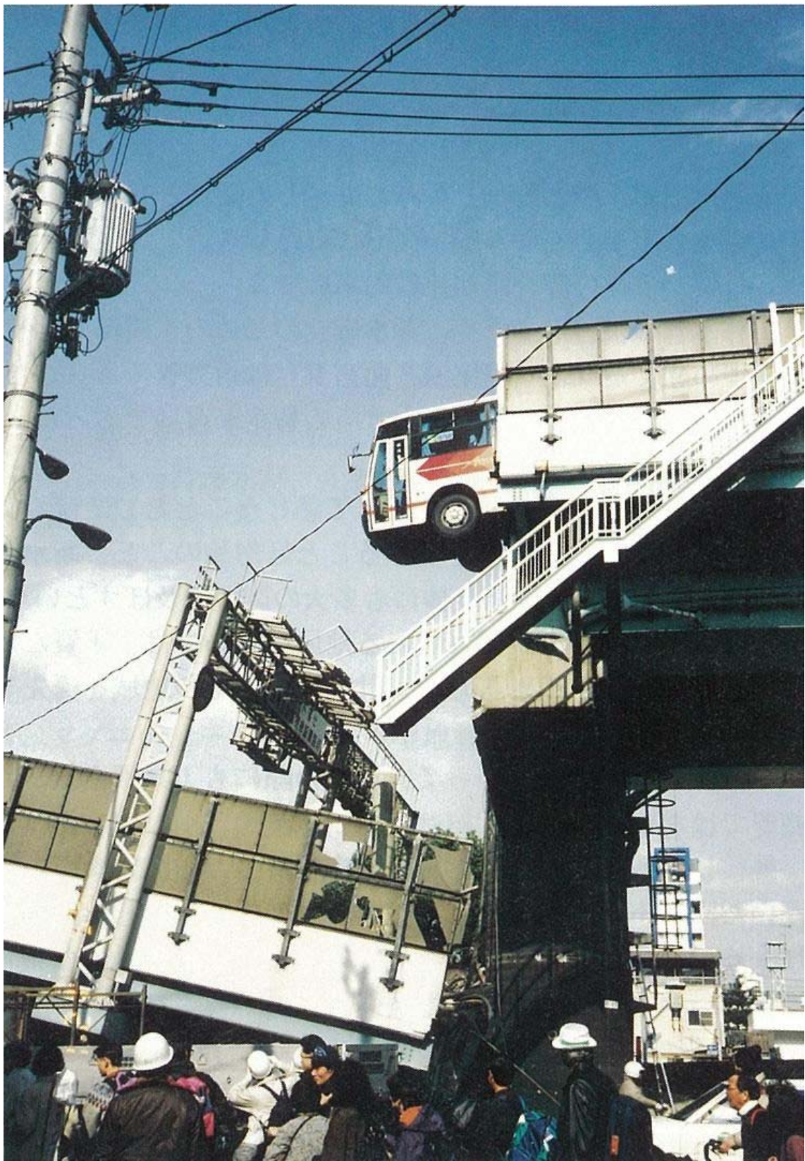
写真6 間一髪、転落を免れたスキーバス（阪神高速神戸線・本町付近） 兵庫県南部地震 （提供）西宮市水道局
