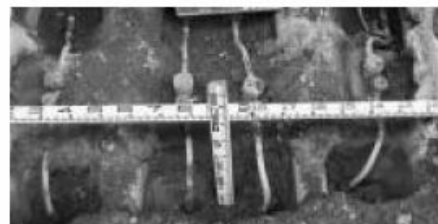
鉛製給水管の布設替え工事
