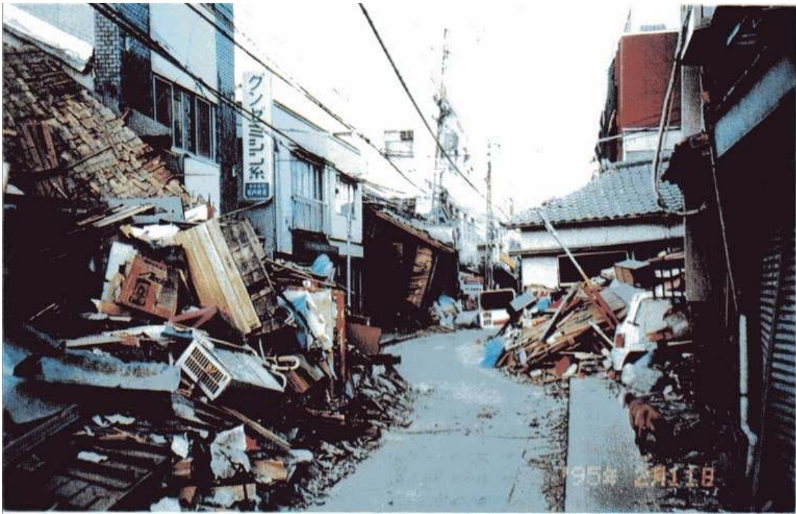
写真5 家屋倒壊による道路封鎖 兵庫県南部地震 (提供) 神戸市水道局
