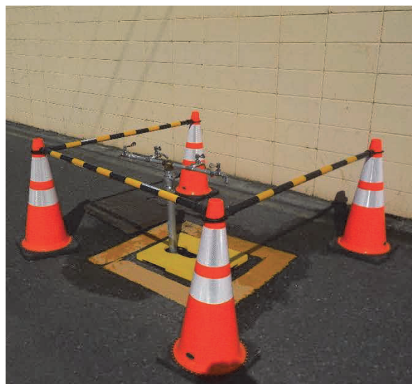
消火栓からの応急給水②
