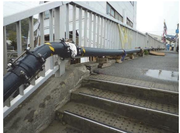
仮設配管(硬質塩化ビニル管)
