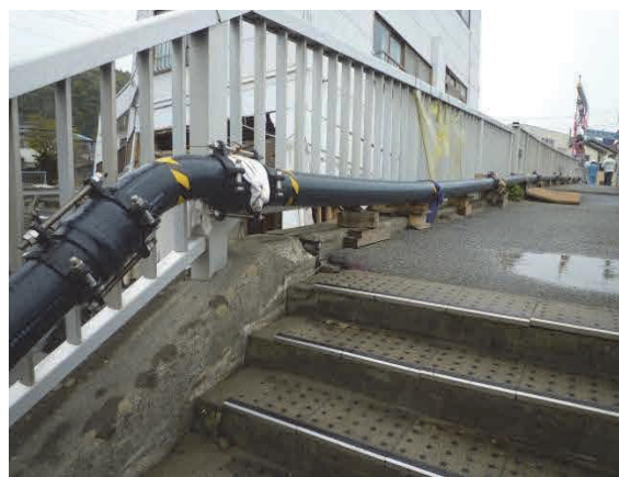
仮設配管(硬質塩化ビニル管)
