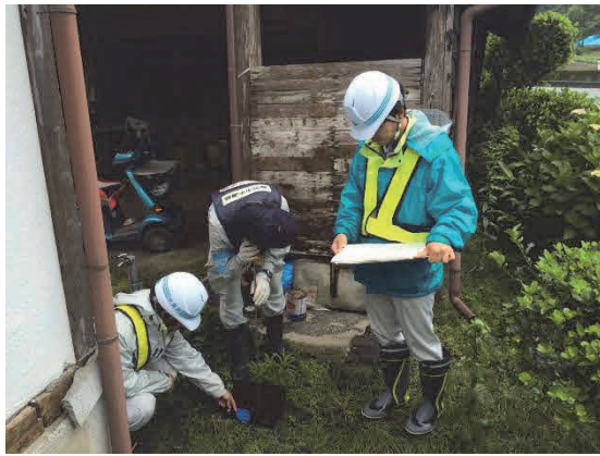
漏水調査作業の様子
