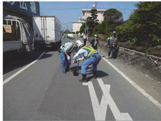
漏水調査作業（バルブ操作）の様子
