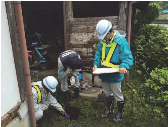
漏水調査作業の様子
