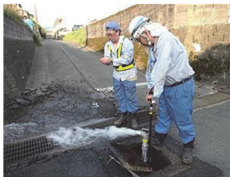
漏水調査作業(管洗浄)の様子
