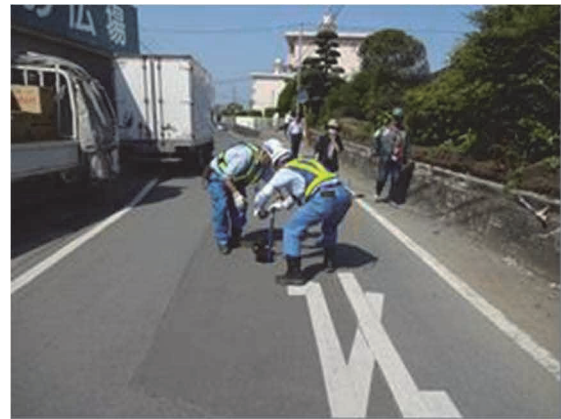
漏水調査作業（バルブ操作）の様子
