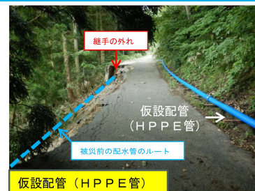
仮設配管（HPP管）
