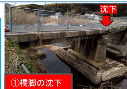
①橋脚の沈下
