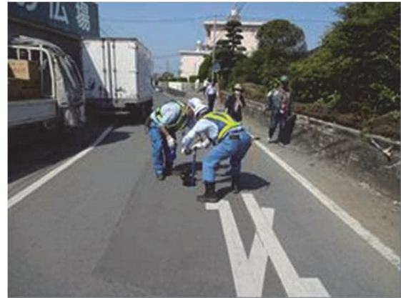
漏水調査作業（バルブ操作）の様子
