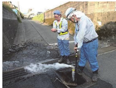
漏水調査作業(管洗浄)の様子
