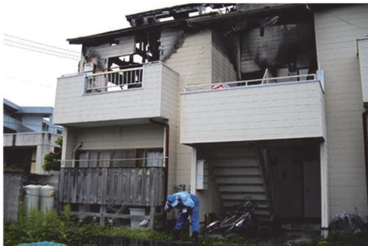
漏水調査作業の様子
