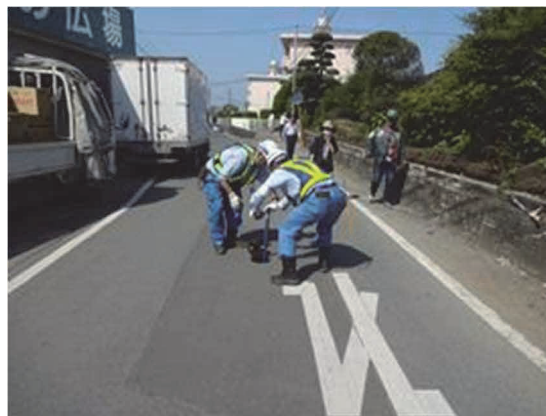
漏水調査作業（バルブ操作）の様子
