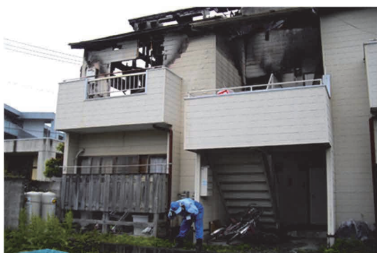
漏水調査作業の様子
