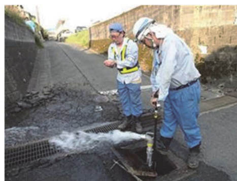
漏水調査作業（管洗浄）の様子
