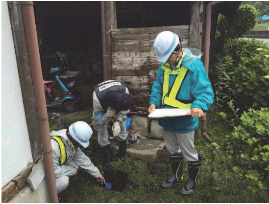
漏水調査作業の様子
