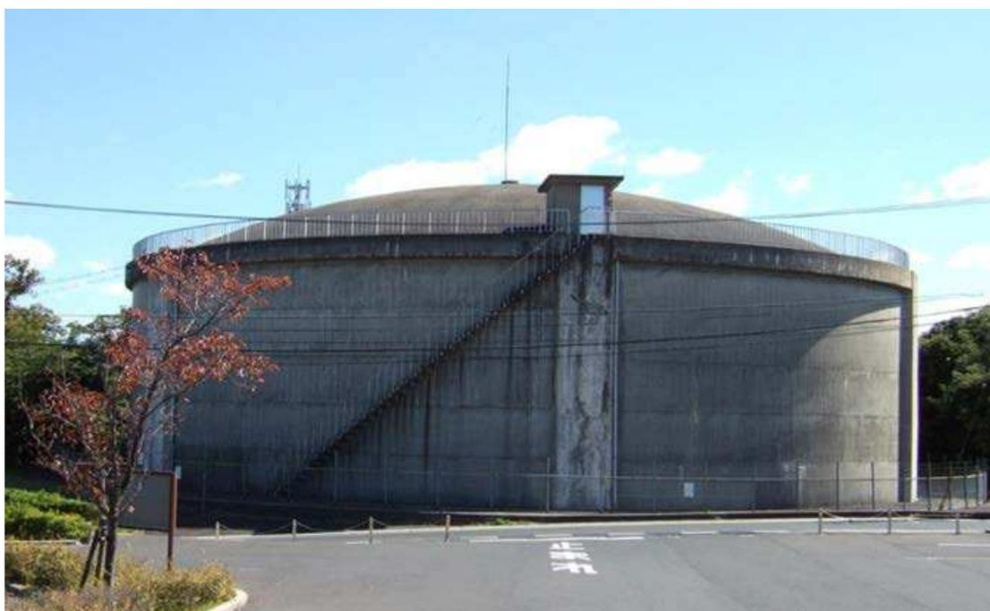
外部壁表面のひび割れや耐力不足が確認された整備前の向山配水池(PC製 容量10,000m<sup>3</sup>)
