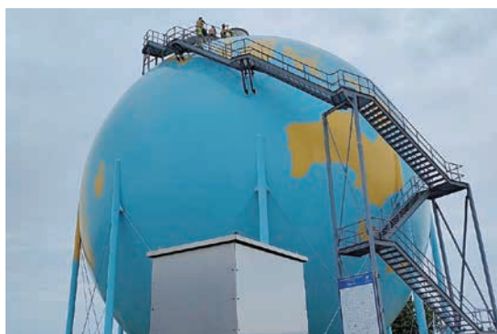
Woodward 下水処理施設における貯蔵タンク
