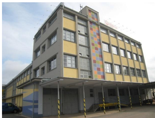
<浄水処理棟の全景>
