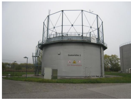
<バイオガス備蓄タンク>
