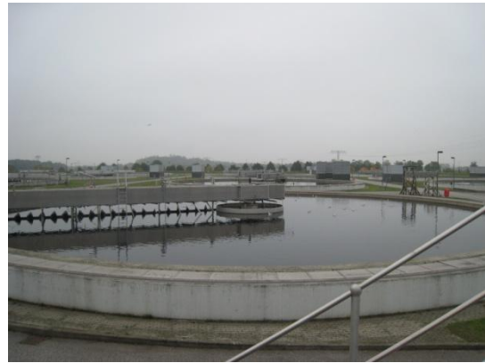
<処理済みの水を貯留しておく池>
