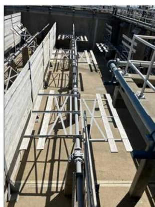
写真8 沈殿池フロキュレーター(羽根が木)
