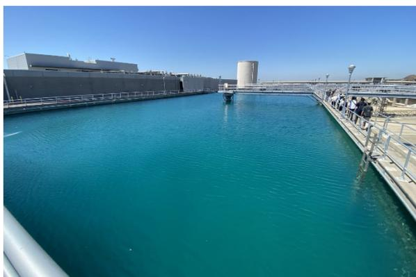
写真-2 ディーマー浄水場の凝集沈殿池
