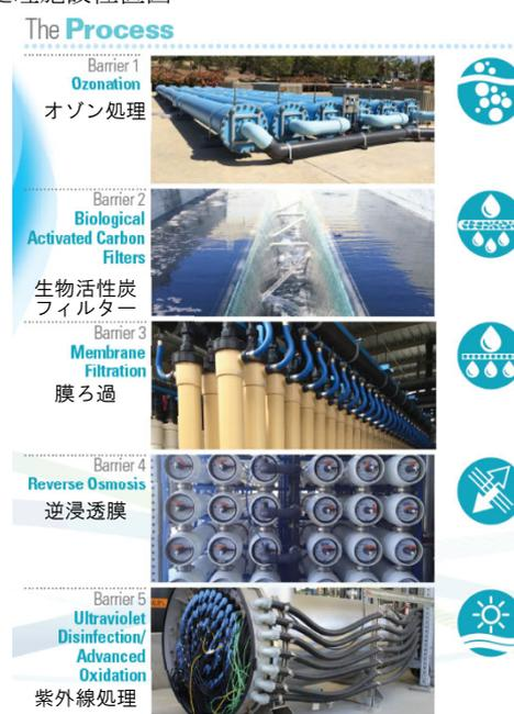
図-19 ピュアウォーター浄水処理工程
