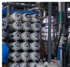
図4-20 膜処理(日本製)
